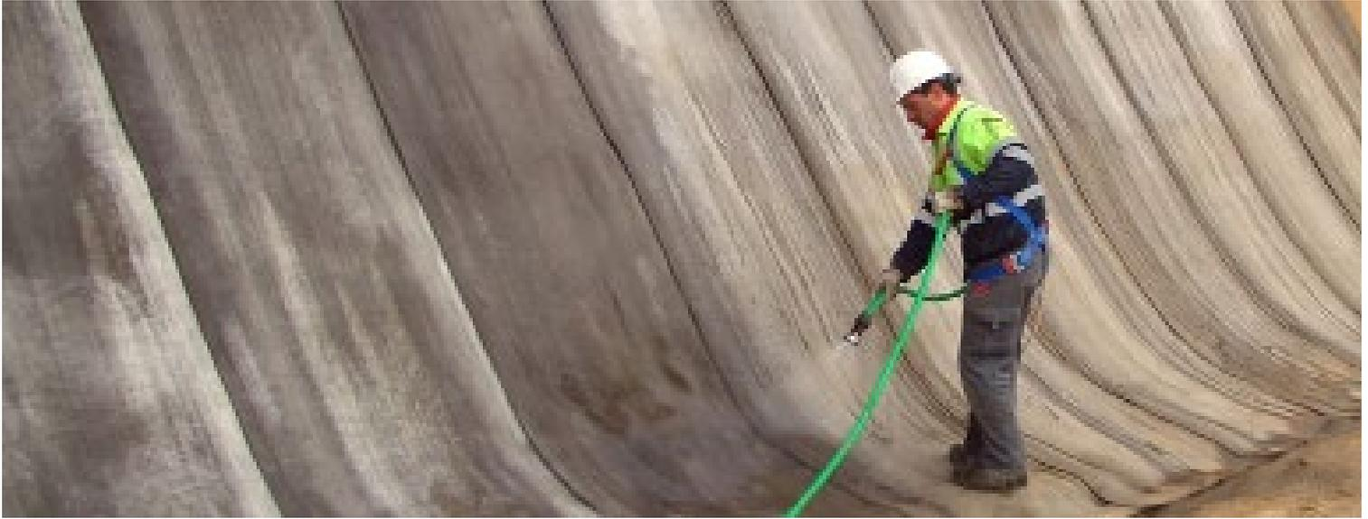
**Besprühen Sie die Gewebeoberfläche mit Wasser bis sie sich nass anfühlt. Dieser Zustand sollte nach Besprühen einige Minuten andauern, ansonsten wiederholen Sie das Einsprühen.**
