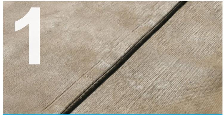
Fig. 2 Überlappendes CC von 100mm
