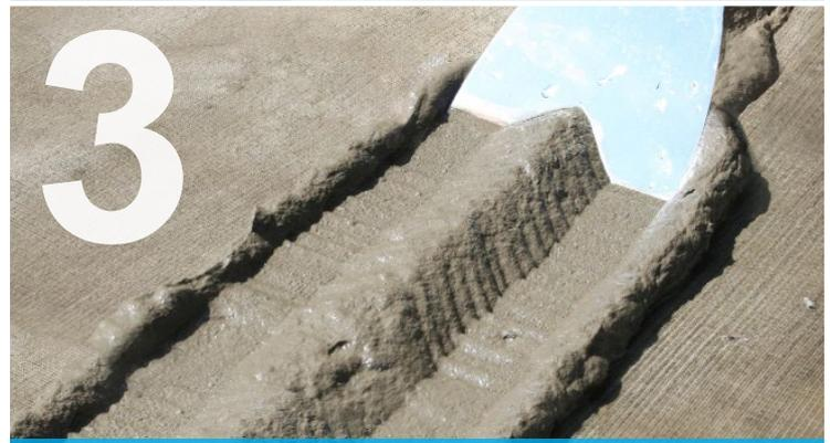
Fig. 4 Anwendung des Spachtels in Rührbewegung
