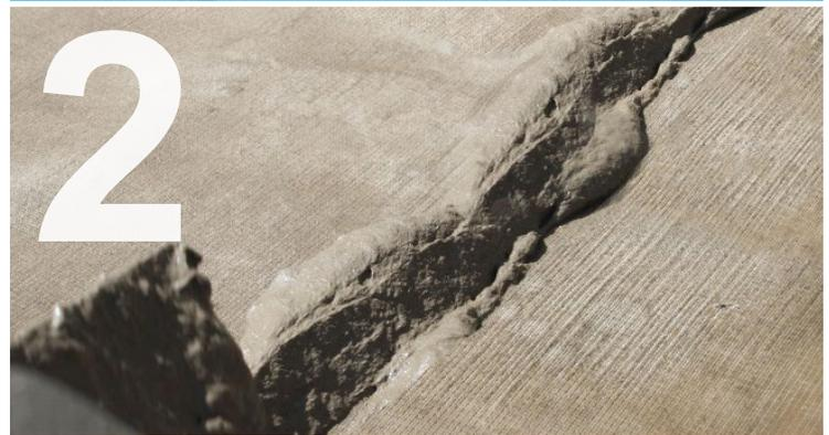
Fig. 3 Ausreichende Verwendung des Mörtels
