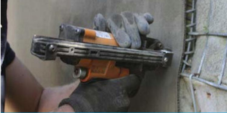
Verbindung mit einer pneumatischen Krampenzange an einem Gabion Korb
