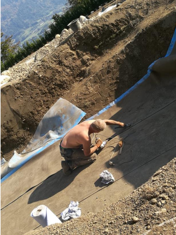
Verschweißung der Bahnen
