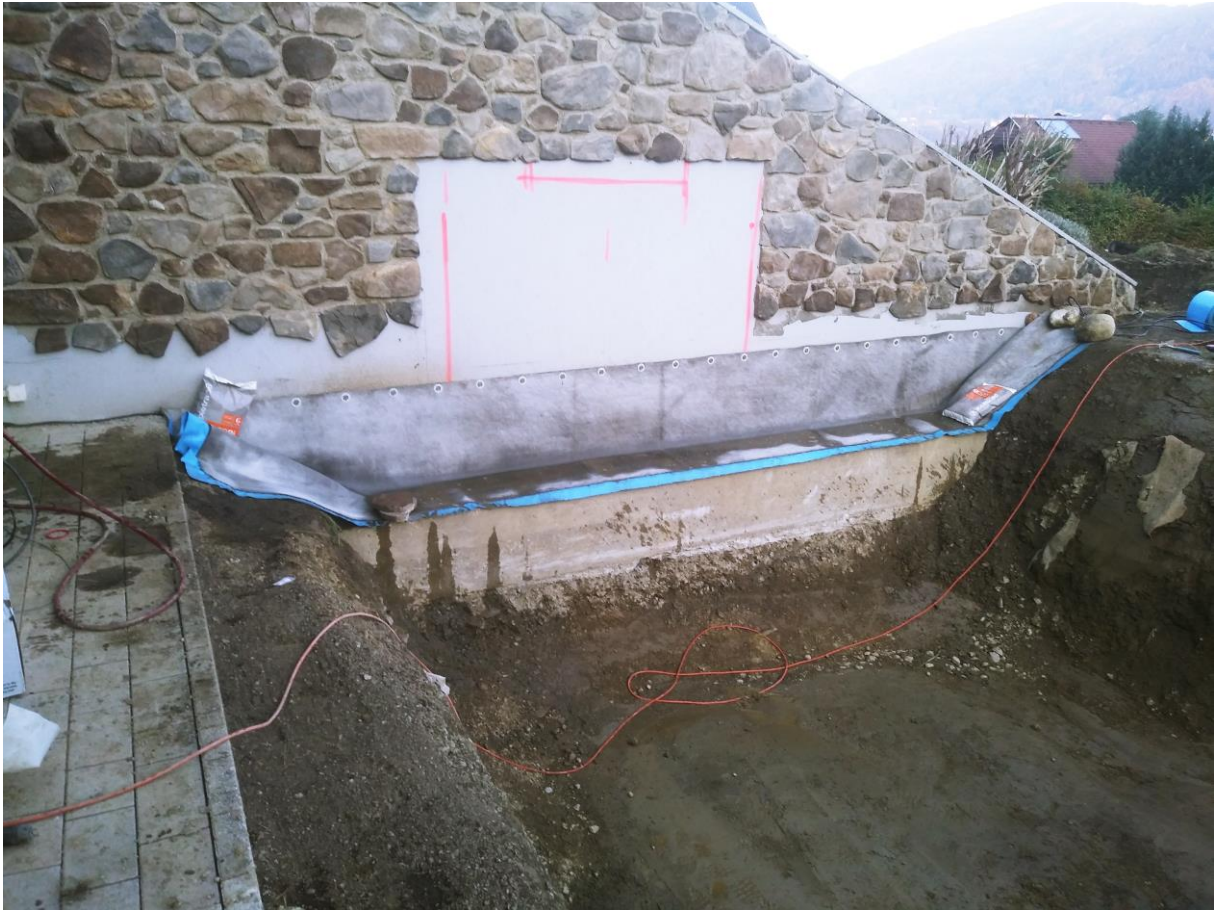
Erste Bahn auf Beton befestigt
