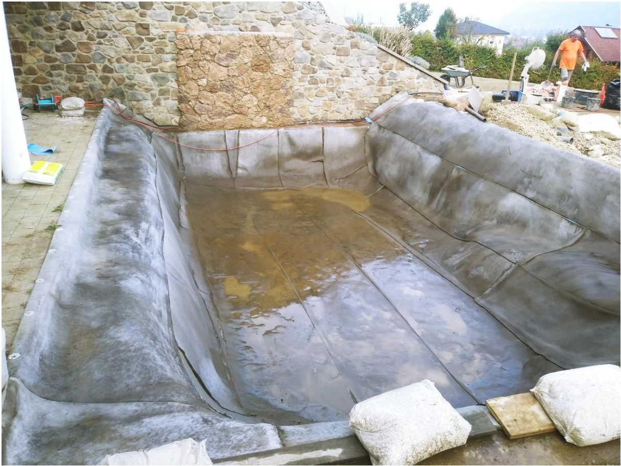
Fertiges Gewebe wird verspachtelt, mit blauer Schwimmbadfarbe gestrichen bzw. mit Kunststeinteppich verspachtelt. (Fotos folgen)
